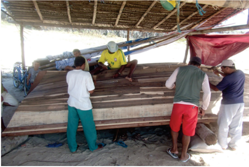
Figura 6. Pescadores construindo embarcação tipo canoa.
