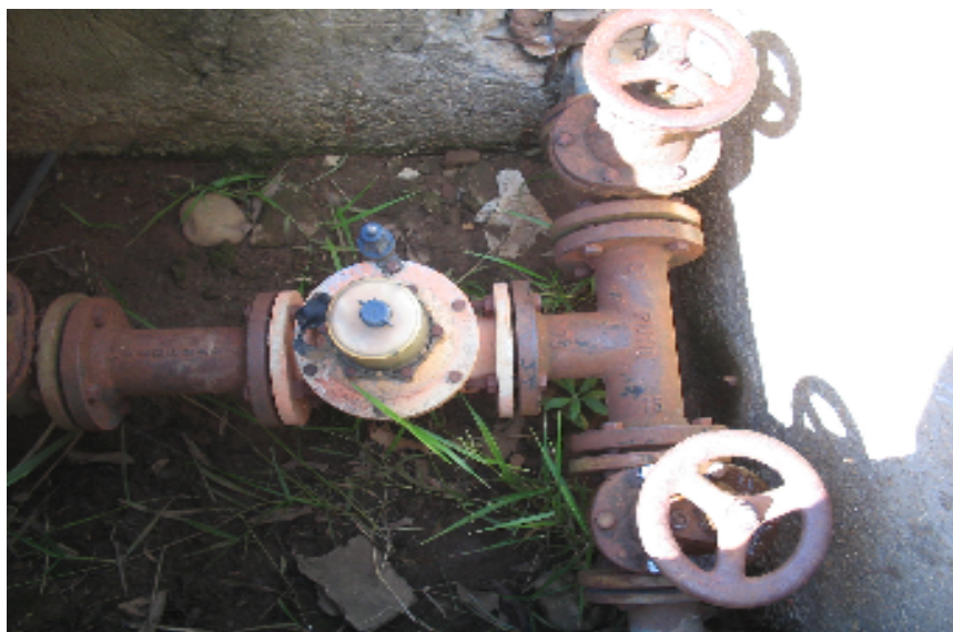
Figura 5 - Válvula reguladora de pressão na entrada de lote.
