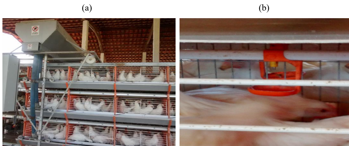
Figura 4 – Equipamentos do Galpão 2: (a) comedouro automático do tipo calha metálico; e (b) bebedouro do tipo nipple
