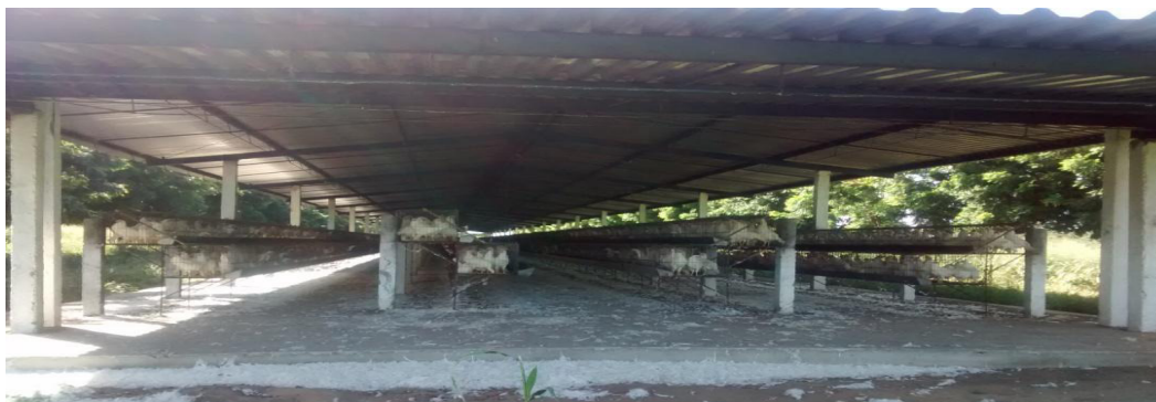
Figura 1 – Galpão de recria convencional com 4 baterias de gaiolas, chamado de Galpão 1
