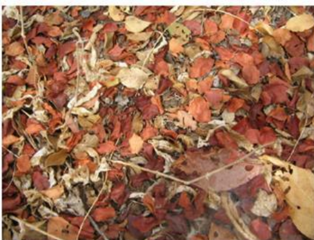
Figura 7 - Detalhe da cobertura morta
