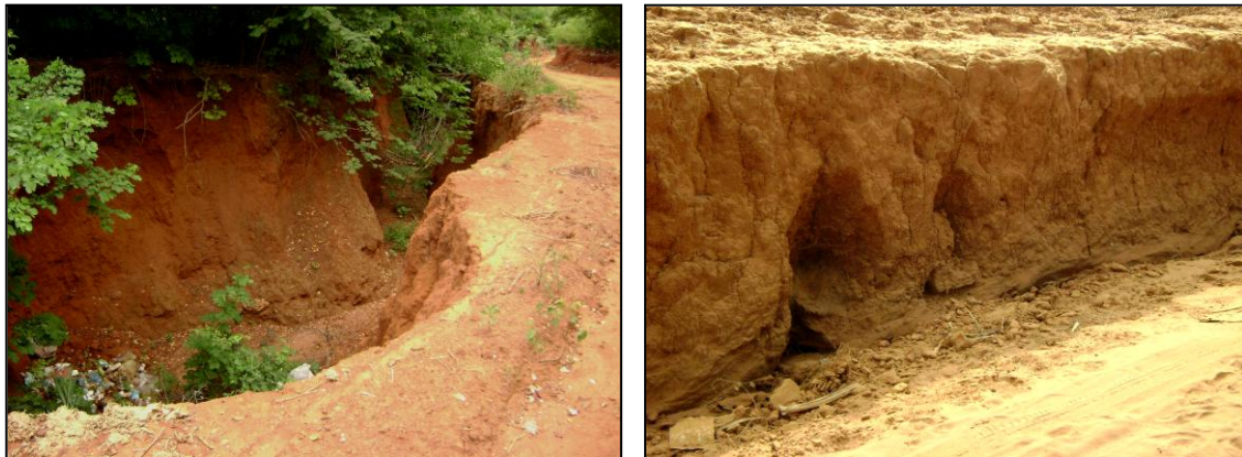
Figura 26 – Presença de voçoroca e corte com remoção de sedimentos
