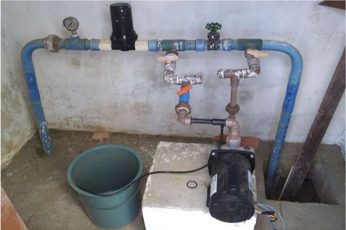
Figura 2 - Cabeçal de controle e sistema de injeção de fertilizantes, Fortaleza, Ceará, 2009.
