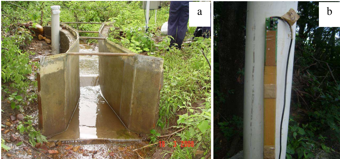
Figura 9 – Calha Parshal (a) e detalhe do sensor de nível (linígrafo) usado para medir a altura da água na calha (b)
