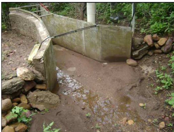
Figura 18 – Depósito de sedimentos a montante da calha Parshall da microbacia B3
