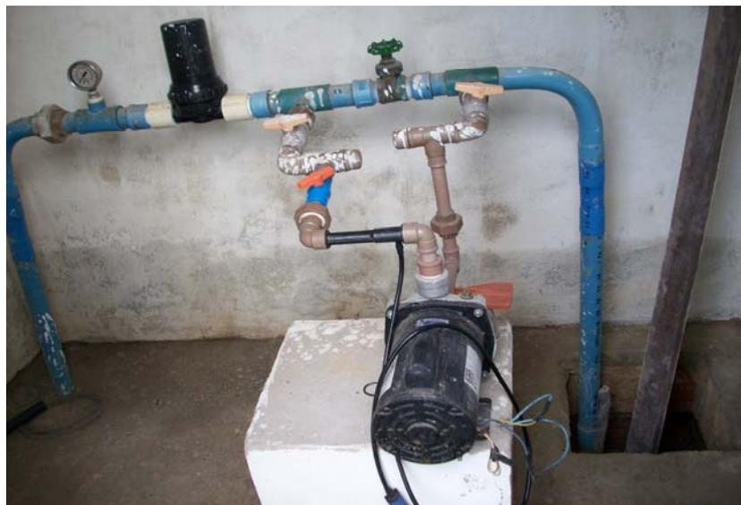
Figura 1 - Cabeçal de controle para a fertirrigação, Fortaleza, Ceará, 2008.
