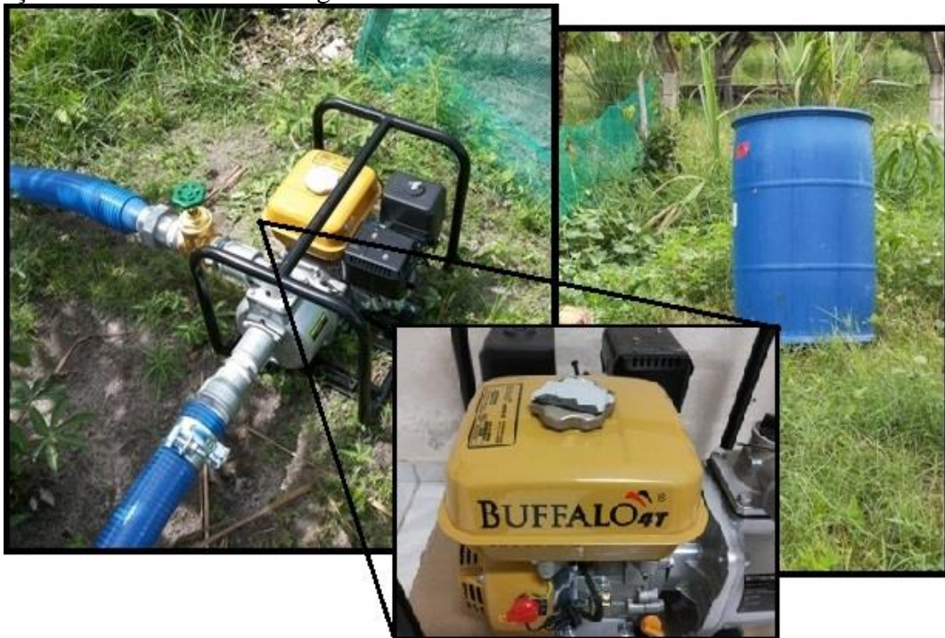
Figura 14 – Conjunto motobomba à gasolina e tambor de 200 L utilizados nos testes de vazão dos poços rasos no Perímetro Irrigado Curu Pentecoste
