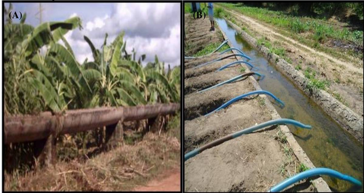
Figura 7 – Canal secundário (A) e canal terciário com adução de água através de sifões (B) no Perímetro irrigado Curu Pentecoste
