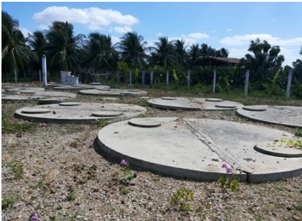
Figura 45 – Estação de tratamento de efluentes localizada no Distrito da Serrota, local próximo ao ponto de coleta (R1)
