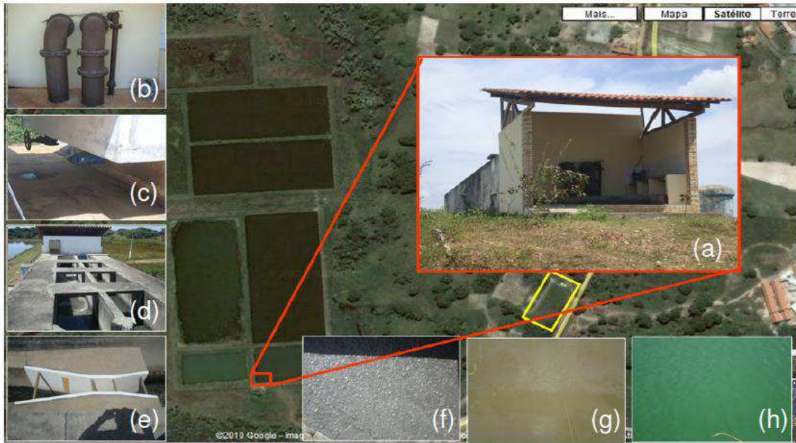
Figura 2 – Ilustração da Estação de Tratamento da CAGECE com detalhes de alguns componentes. (a) Estação de tratamento preliminar, (b) tubulações de chegada de esgoto doméstico, (c) local de limpeza da caixa de areia, (d) Detalhe da caixa de areia, (e) Calha Parshal, (f) água esgoto doméstico bruto, (g) esgoto na lagoa anaeróbia, (h) esgoto tratado em lagoa facultativa. ETE, Aquiraz, CE, 2010
