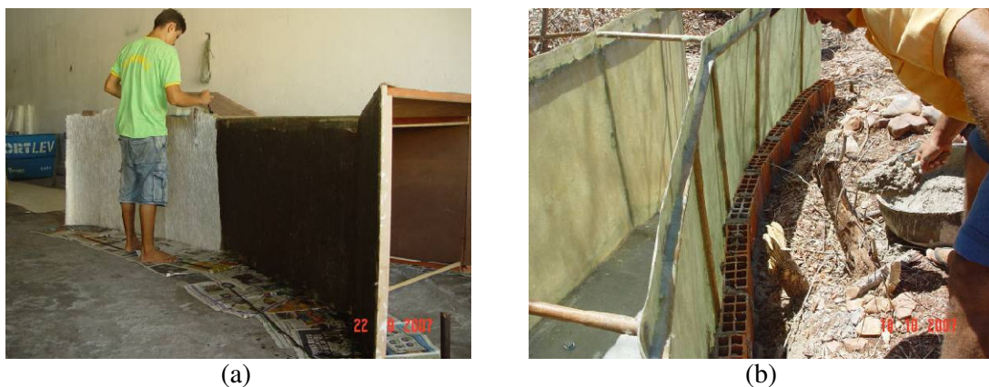
Figura 15 – Confeção das calhas Parshall em fibra de vidro (a) e instalação em campo com estrutura de alvenaria (b).
