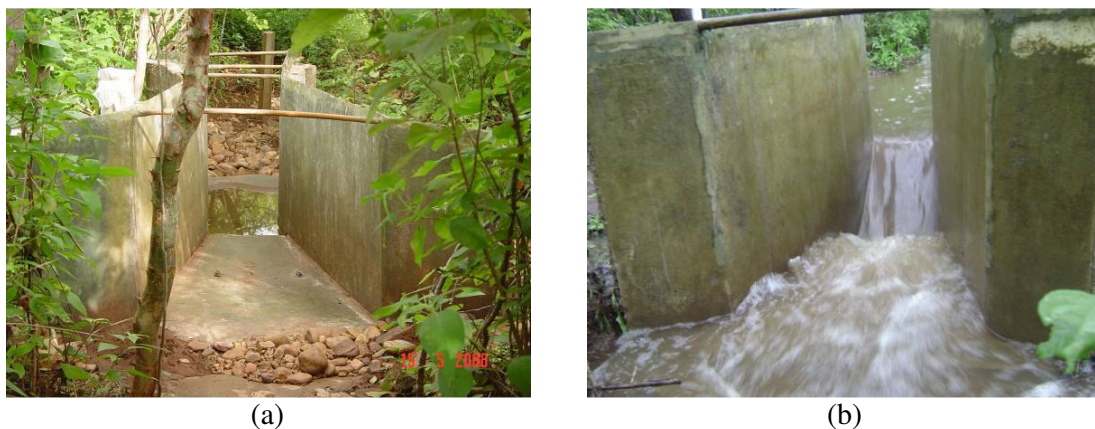
Figura 16 – Detalhe da calha Parshall instalada em campo (maio 2008), (a) visão geral, (b) em funcionamento.
