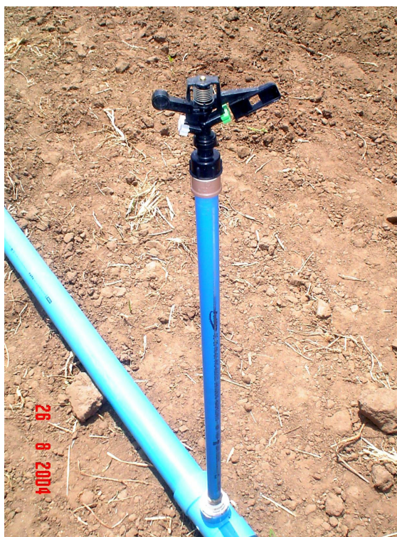
Figura 4 – Detalhe da tubulação de subida e do aspersor.
