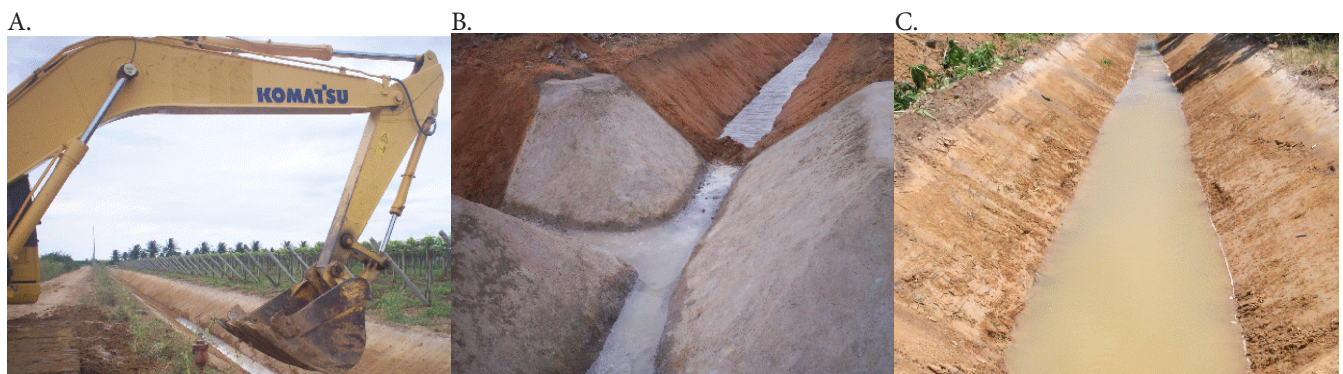
Figura 1. (A) Retroescavadeira em atividade de manutenção no canal de drenagem; (B) revestimento em encontro de canais e (C) canal em funcionamento
