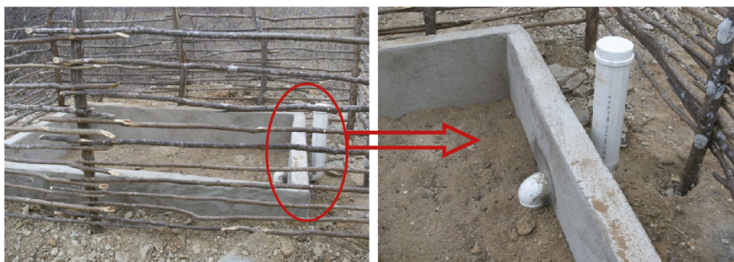
Figura 27. Módulo de fossa verde de controle, usada para avaliação do uso consuntivo da água, na Escola do Campo, Quieto, em outubro de 2011.
