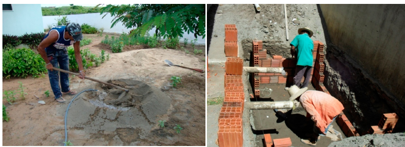
Figura 23. Método construtivo da ‘caixa’ de um módulo de fossa verde: [a] escavação da trincheira; [b] limpeza e nivelamento da trincheira; [c] preparação da massa; [d] impermeabilização do fundo e construção das paredes.
