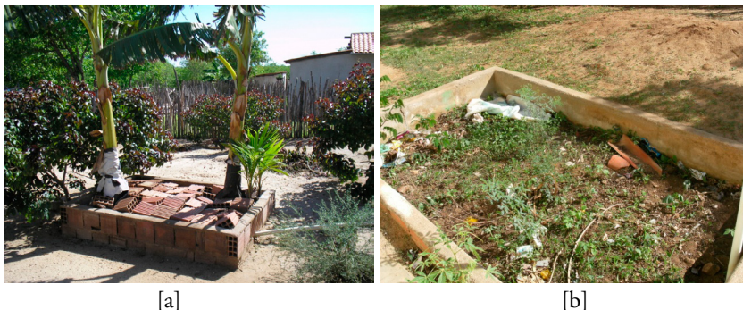
Figura 34. Operação inadequada de módulos de fossa verde: [a] cobertura do substrato por tijolos reduz a evaporação e, portanto, a eficiência da tecnologia (dezembro de 2011); [b] módulo abandonado, sem vegetação ou cuidados adequados (março de 2012).
