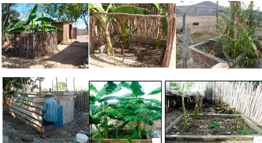
Figura 33. Exemplos de cercas de proteção contra a presença de animais em módulos de fossa verde no A25M (junho de 2011).
